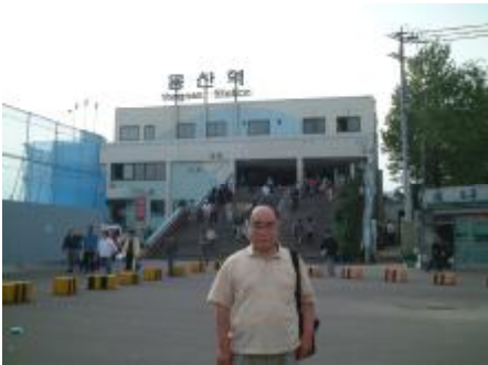
龍山駅(旧駅を建て替え工事中)
